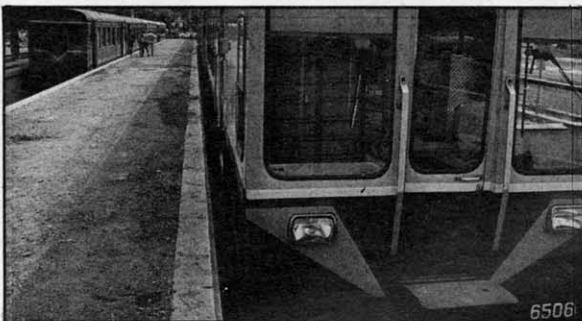
Por fin se inician este mes las obras de la estación de Amara.
