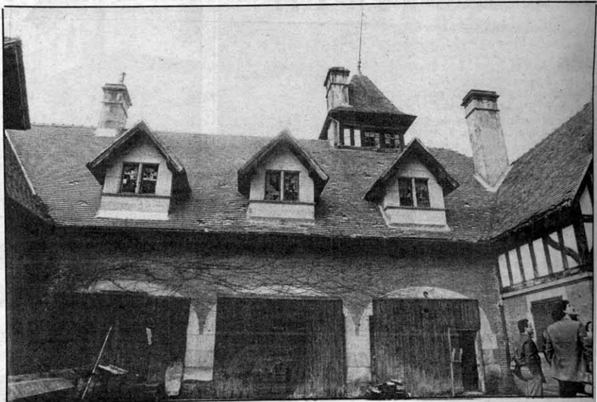
Antes del comienzo de las obras varios pabellones del palacio se encontraban en situación de abandono. (Foto Postigo)
