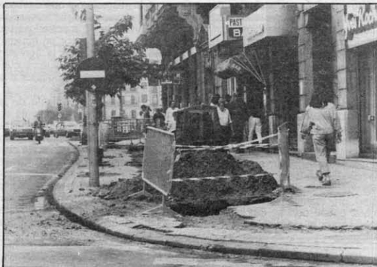
Obras en las aceras de los barrios. Mientras en el centro de San Sebastián las obras de levantamiento de aceras finalizaron antes de la temporada, en los barrios se siguen quitando baldosas o, como en este caso, al comienzo de la calle Miracurz, abriendo profundos agujeros que inutilizan peatonalmente más de la mitad de la acera. Es de suponer que para Semana Grande, este lugar tan transitado a la hora de los fuegos artificiales, este arreglado. (Foto Postigo)
