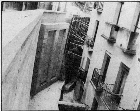
Parte del muro se sustenta sólo por vigas metálicas. (Foto Postigo)
